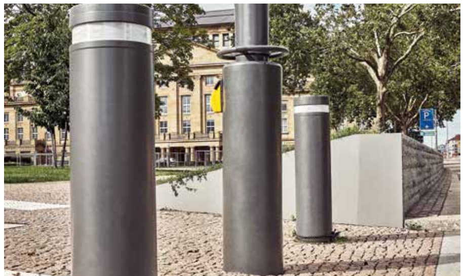
Kombination aus Ableitmaßnahme und Fixpollern
